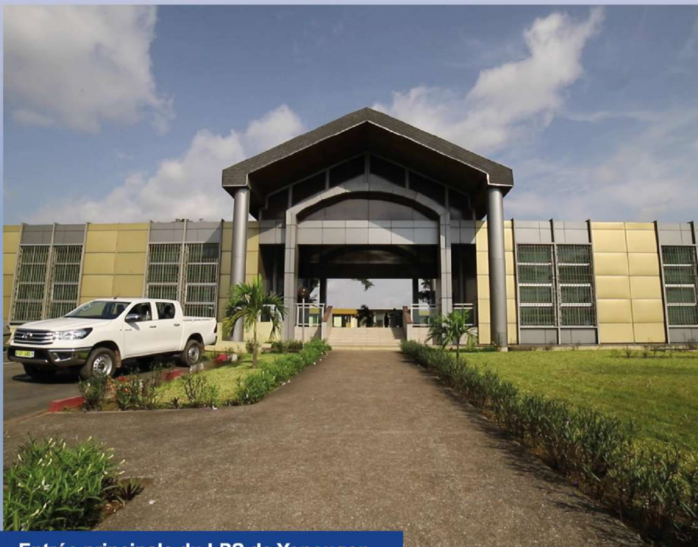
Entrée principale du LPS de Yopougon
