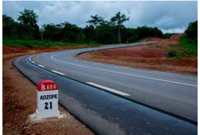
C2D ROUTE_Renforcement de la route Adzopé-Pont Comoé
