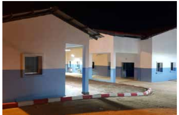
C2D Santé _Construction et équipement de l'Hôpital Général de Duekoué
