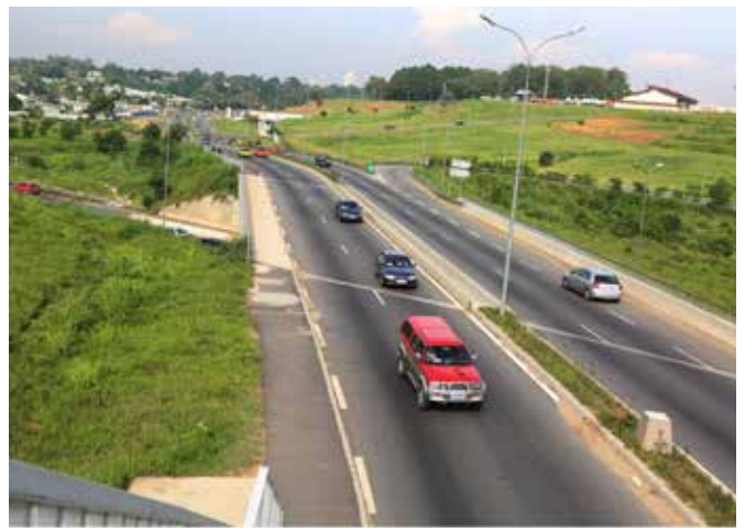
C2D ROUTE_Construction du Boulevard de France Redressé (Abidjan)
