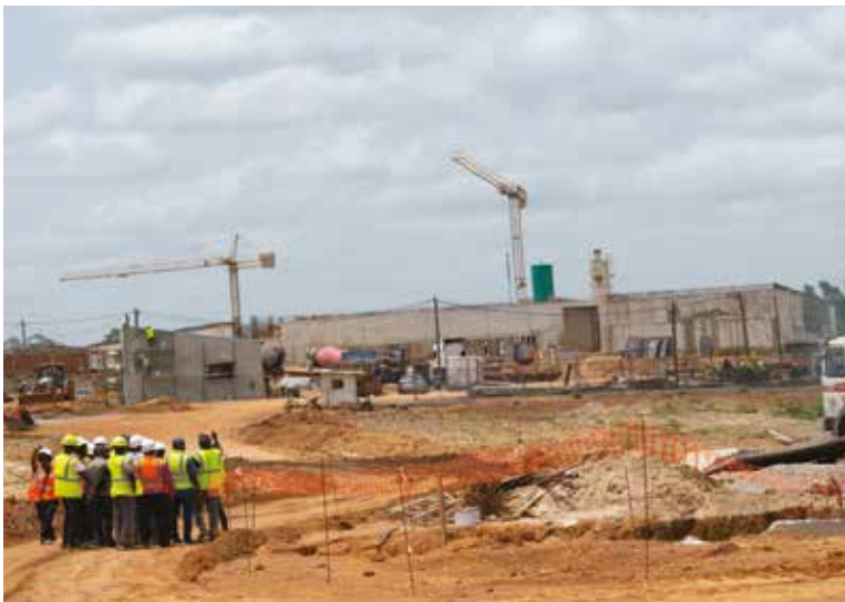
C2D JUSTICE_Maison d'Arrêt et de Correction de Guiglo en construction
