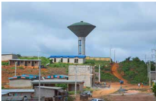
C2D EAU_Construction du château d'eau de Duékoué
