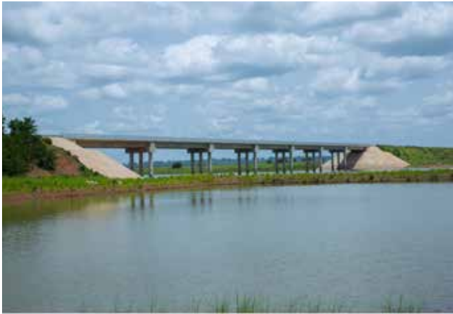
C2D ROUTE_Construction du pont de Béoumi sur le fleuve Bandama
